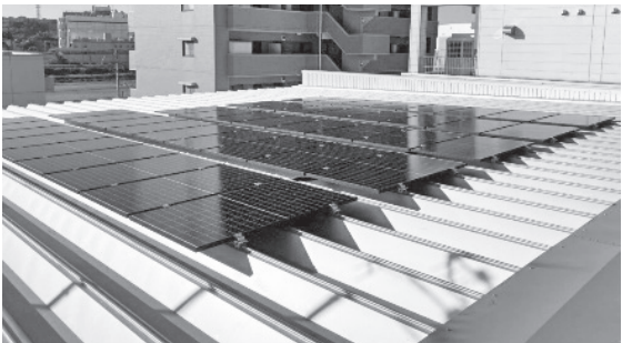
マテックス・横浜営業所に設置された、地産地消「LED」スキームの太陽光発電所
